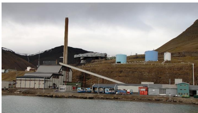
Elektrociepłownia węglowa Longyear Energiverks dostarcza energię elektryczną i ciepło dla miasta Longyerbyen na Svalbard (Spitsbergen). Roczne zużycie węgla wynosi 25 000 ton. Elektrociepłownia produkuje 64 GWh energii cieplnej oraz 41 GWh prądu
