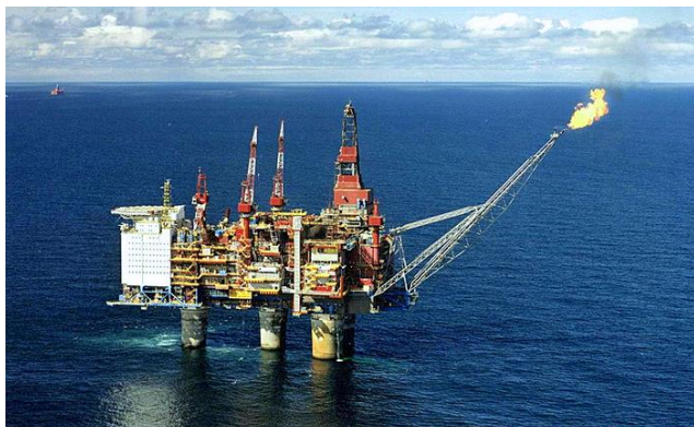
Platforma Gullfaks to jedna z wielu platform, na których Statoil wprowadził zarządzanie energią.
