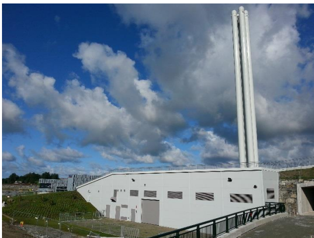
Ciepłownia Forus Nord ma na dzień dzisiejszy dwa kotły gazowe, każdy po 15 MW. Centrala zostanie z czasem powiększona o dodatkowe dwa kotły, jeden kocioł elektryczny i jeden kocioł gazowy, co pozwoli zapewnić łącznie do 60 MW energii cieplnej.
